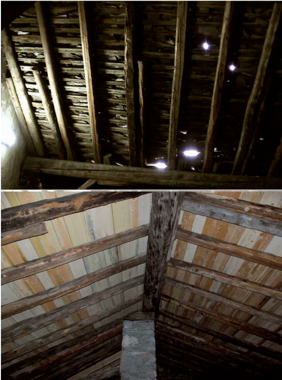
Il vano della cattedrale, prima e dopo il rifacimento della copertura
