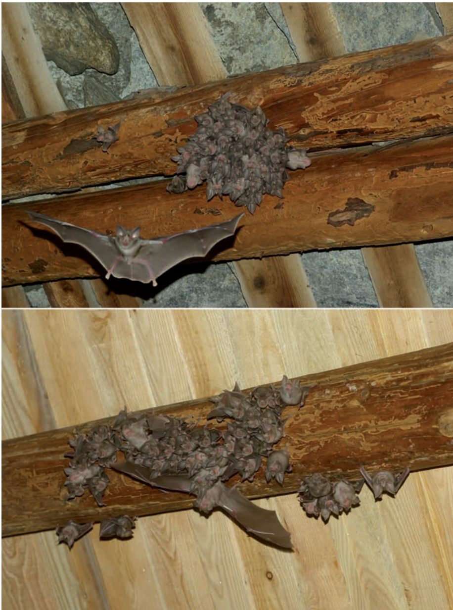
Piccoli rinolofi appigliati a travi della vecchia copertura conservate nel restauro: prima del rifacimento del tetto e dopo l'intervento.
