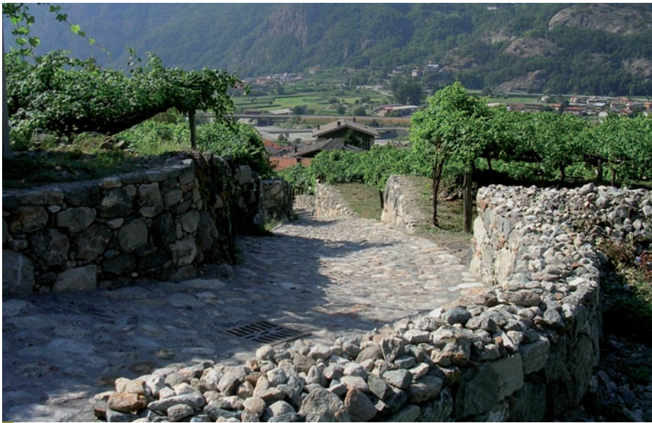
Beneficio ricollegabile alla funzione specifica e primaria della strada interpoderale - Donnas, viabilità rurale a servizio di vigneti - Loc. Moje
