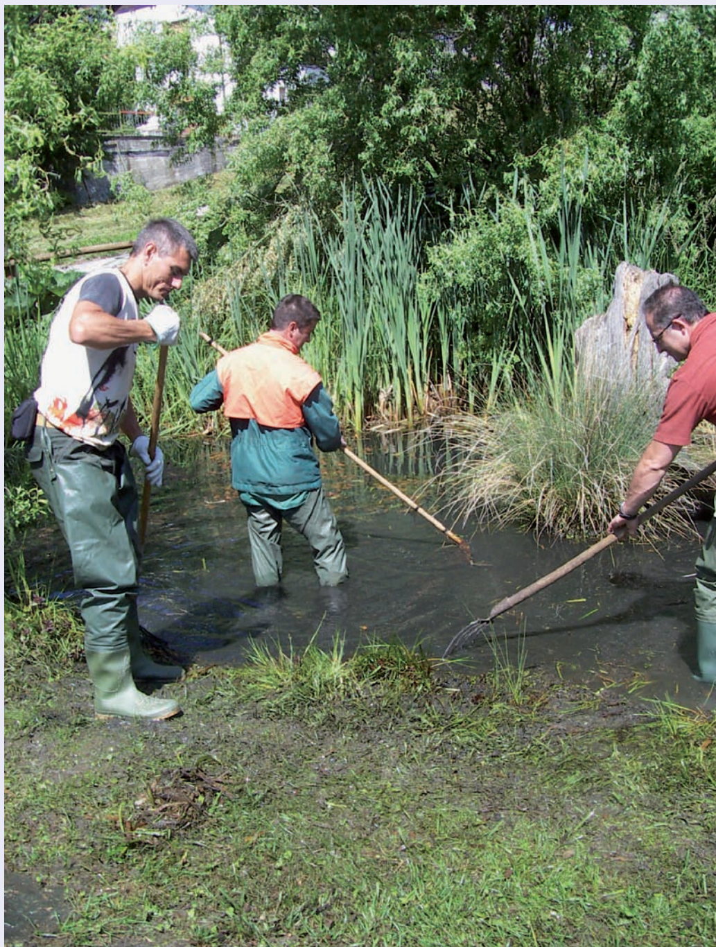
Manutenzione straordinaria a Le Coin à l'ombre du Clocher di Doues
