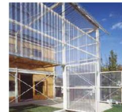
riqualificandone l'immagine complessiva; in secondo luogo poiché i volumi delle serre - se adeguatamente collocati - consentono di modificare la volumetria dell'edificio, ad es. semplificandone l'articolazione spaziale o riducendone l'imponenza, scomponendone idealmente il volume costruito. Sono sempre da evitare vetri specchianti o comunque con colorazioni tali da renderli incongruenti con le vetrate tradizionali.
