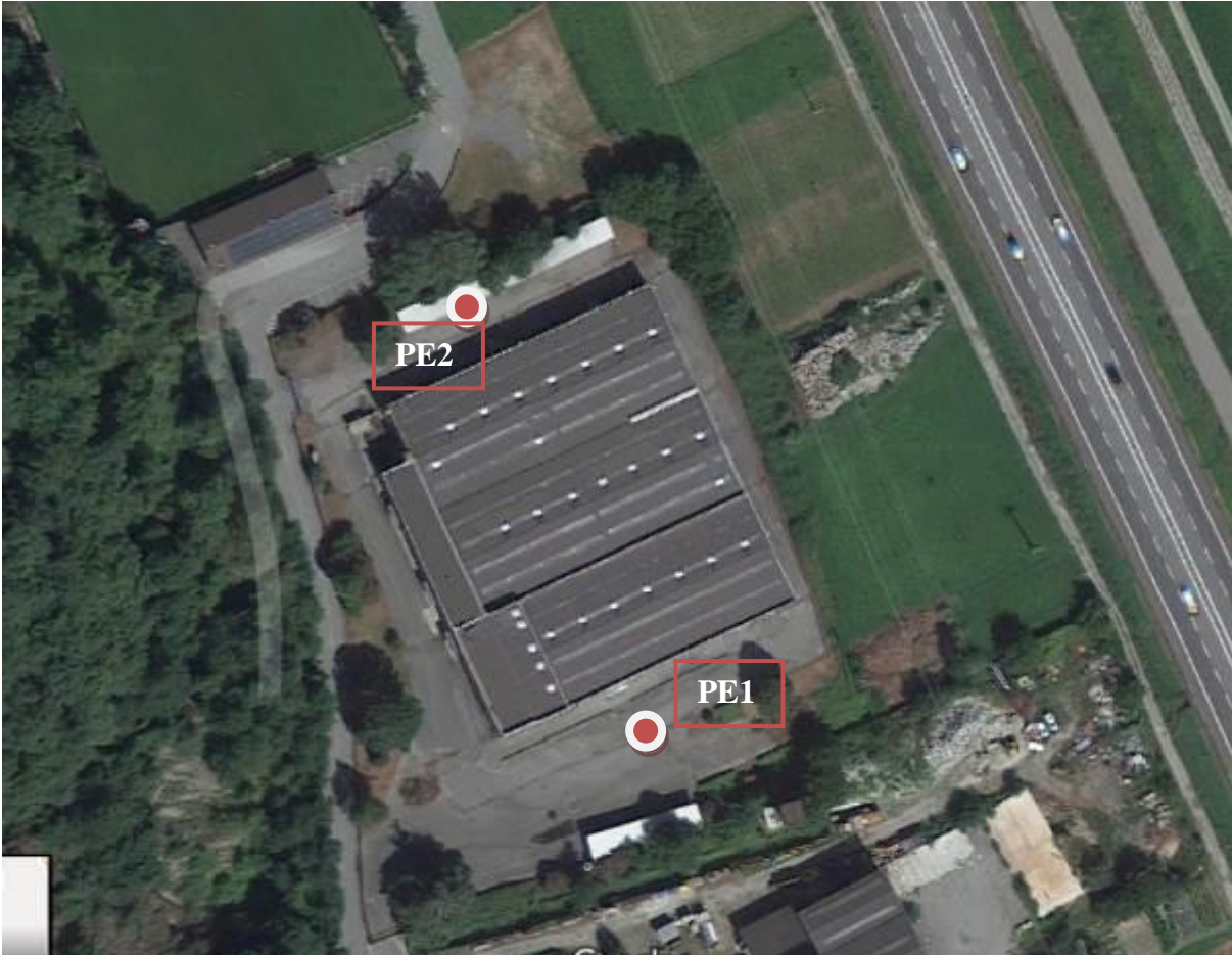
Figura 7 – Identificazione delle postazioni di emissione nella presente relazione presso unità operativa Metallurgica Valdostana Srl
