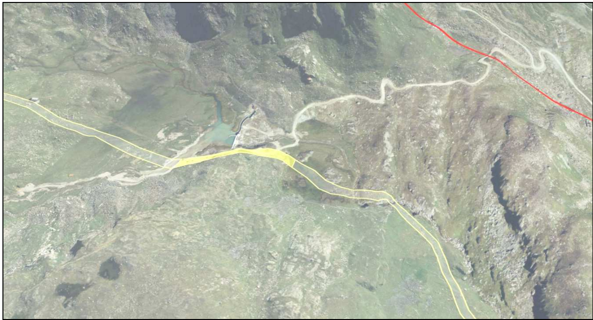
Fig. 18.3 – Settore C tratto 6
