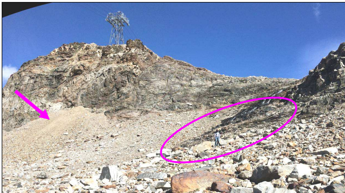
Fig. 8.3 – Area di sistemazione materiale – confronto costruzione del funifor (freccia)
