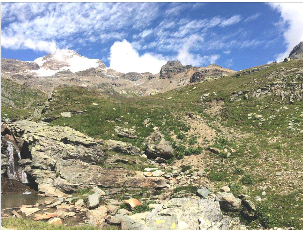
Fig. 21.3 – Settore C tratto 7, realizzazione guado per interferenza con il torrente Endrebach
