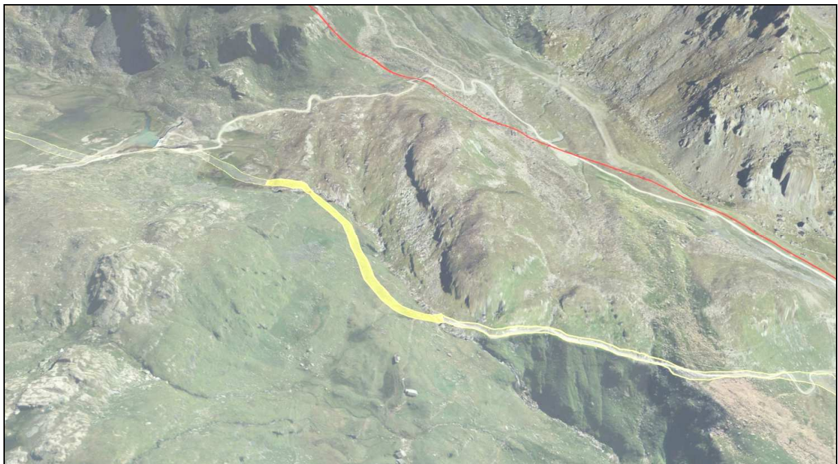
Fig. 20.3 – Settore C tratto 7
