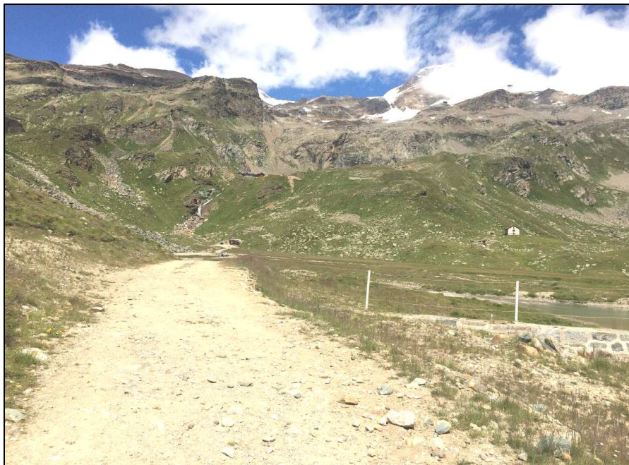
Fig. 19.3 – Settore C tratto 6
