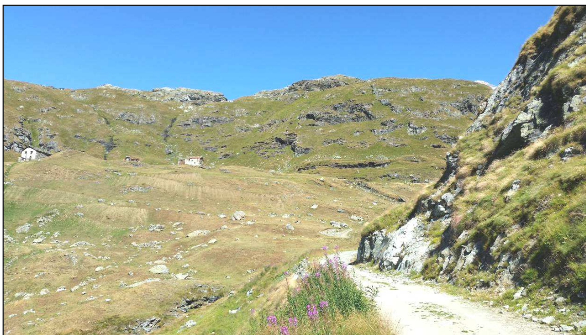
Fig. 26.3 – Settore D tratto 8, strada sterrata verso Gaveno (scavi in roccia)
