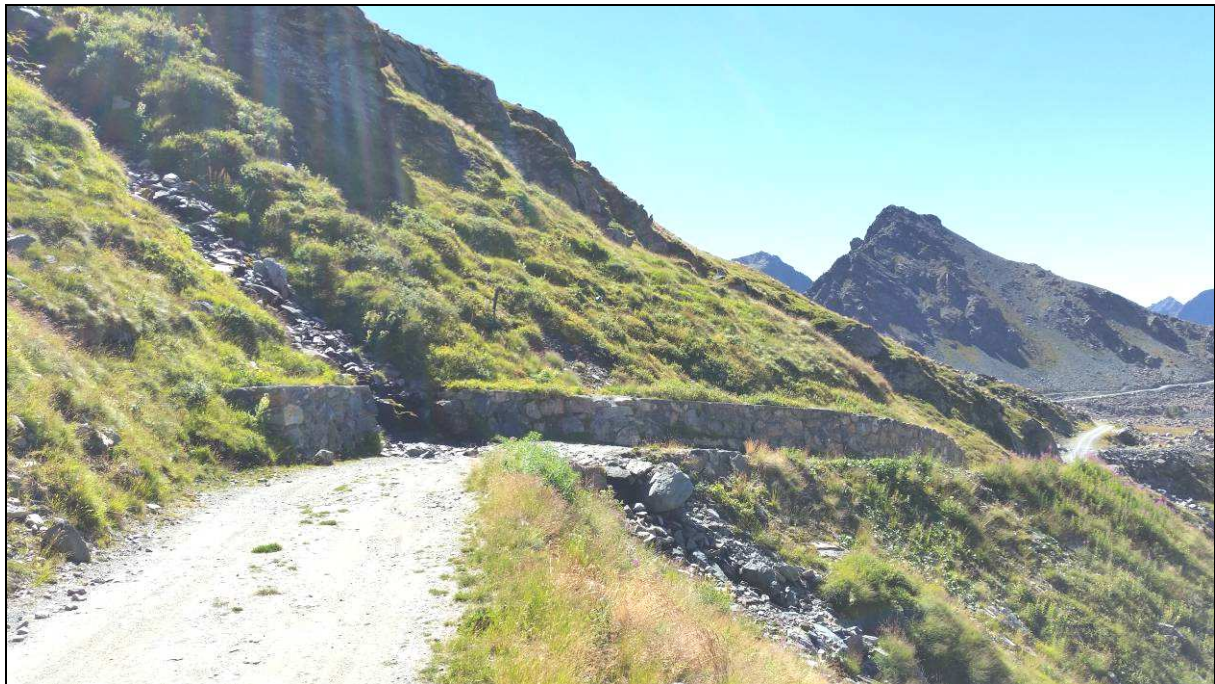
Fig. 27.3 – Settore D tratto 8, scogliere di controripa esistenti
