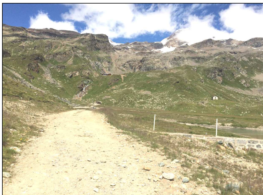
Fig. 19.3 – Settore C tratto 6
