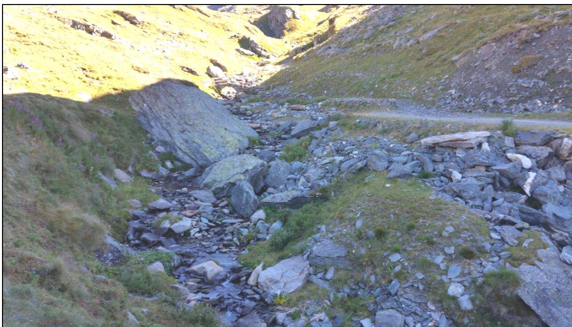
Fig. 25.3 – Settore D tratto 8, in corrispondenza del guado sull'Endrebach
