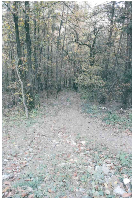
Tratto di tracciato dove è già stata posata una tubazione all'interno del bosco
