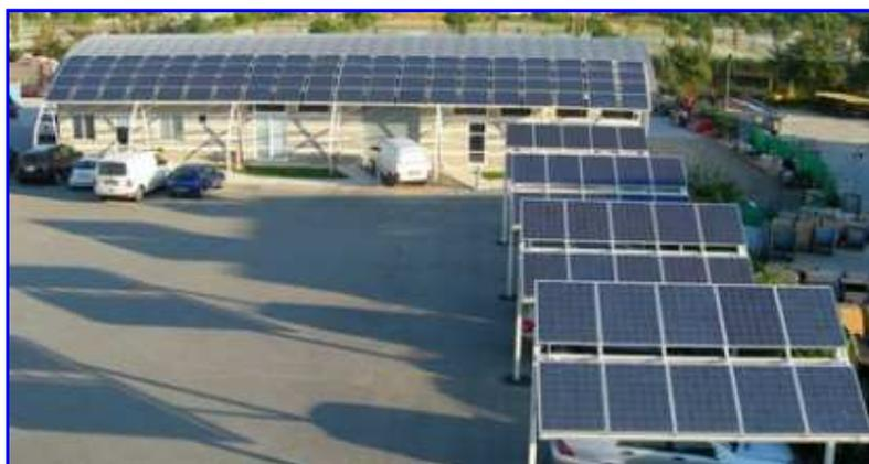
Il nuovo impianto è composto da **120 moduli fotovoltaici in silicio monocristallino** della potenza di 165 Wp ognuno, posti seguendo la curvatura del capannone preesistente, che hanno creato un **frangisole utile per migliorarne il comfort abitativo** tutto l'anno.
