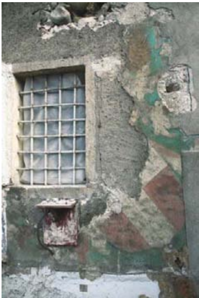
34. Facciata meridionale. Particolare dello stemma. (G. Di Carlo)
