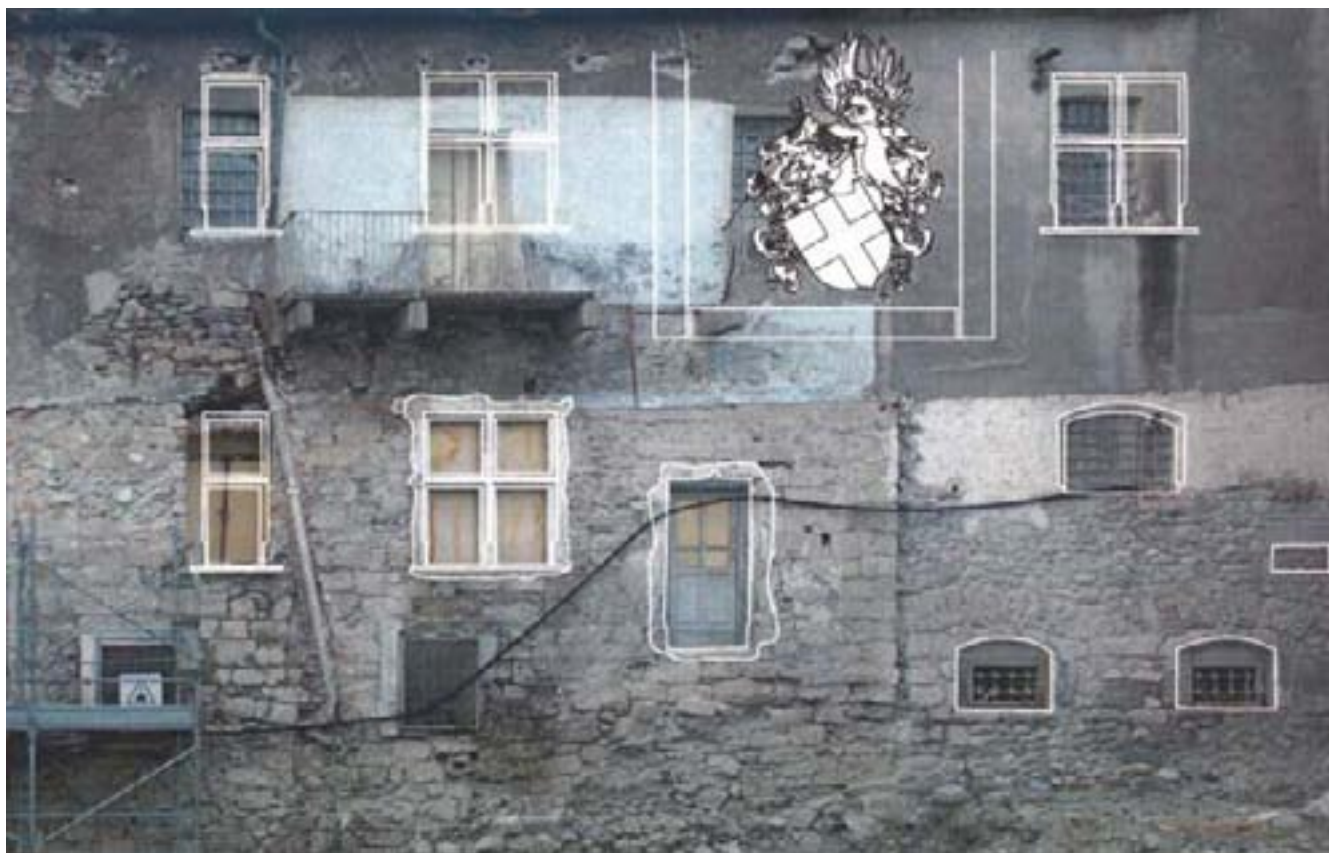
32. Ipotesi ricostruttiva dello schema delle aperture e dell'apparato decorativo, sulla fronte sud del corpo di fabbrica addossato alla cinta nord. (G. Di Carlo, elaborazione M. Cortelazzo)
