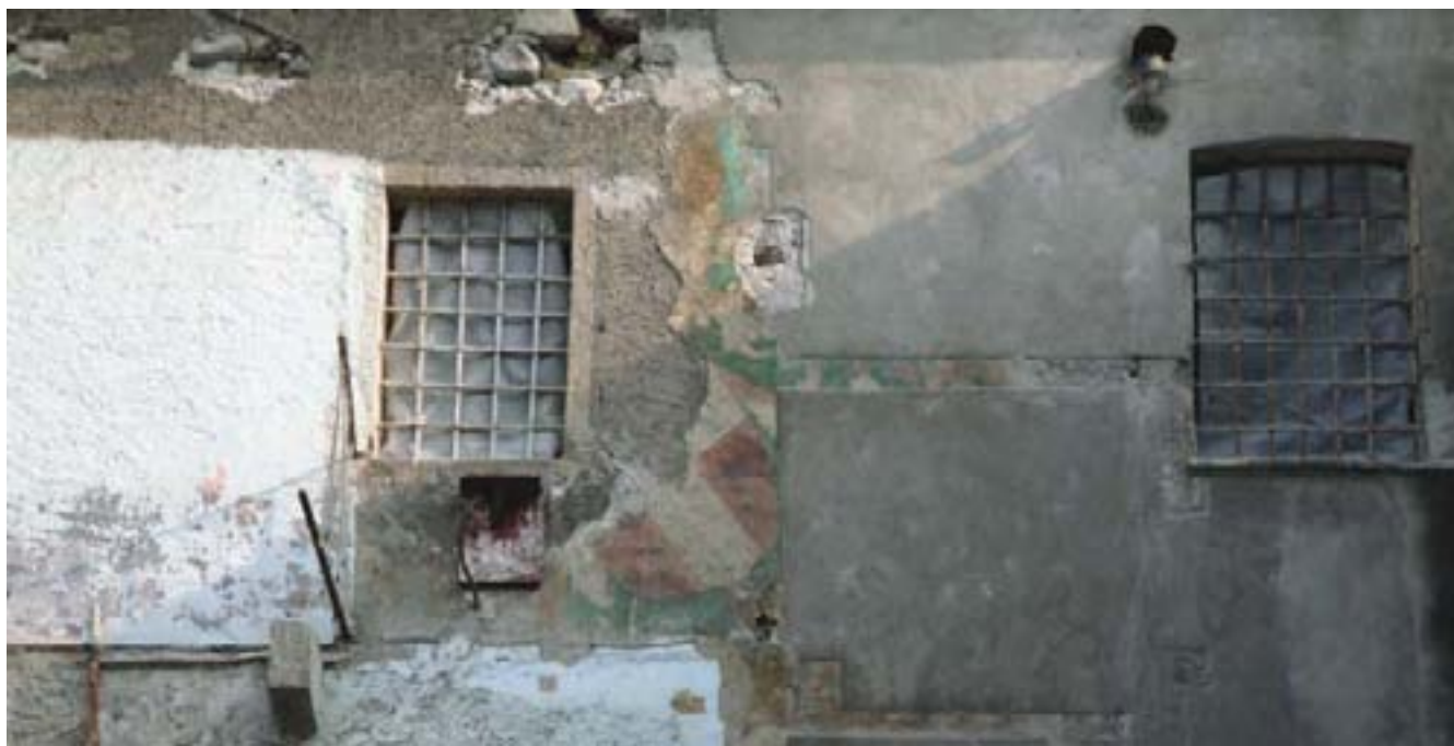
33. Facciata meridionale. Veduta generale. (G. Di Carlo)
