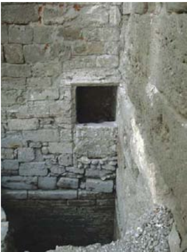
18. Il passaggio nell'angolo a nord-est che dava accesso al sottoscala ed al passaggio in rottura per l'ingresso all'interno della torre. (M. Cortelazzo)
