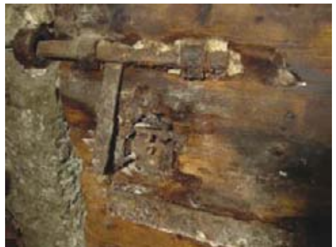
6. Particolare della serratura della porta. (M. Cortelazzo)
