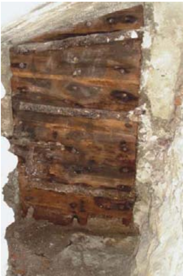
5. La porta lignea, della fine del XVII secolo, che permetteva la chiusura del passaggio aperto in rottura. (S.E. Zanelli)
