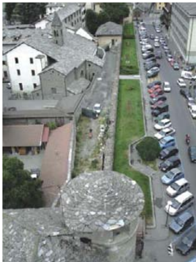
16. Tratto di cinta muraria lato nord verso ovest. (M. Cortelazzo)
