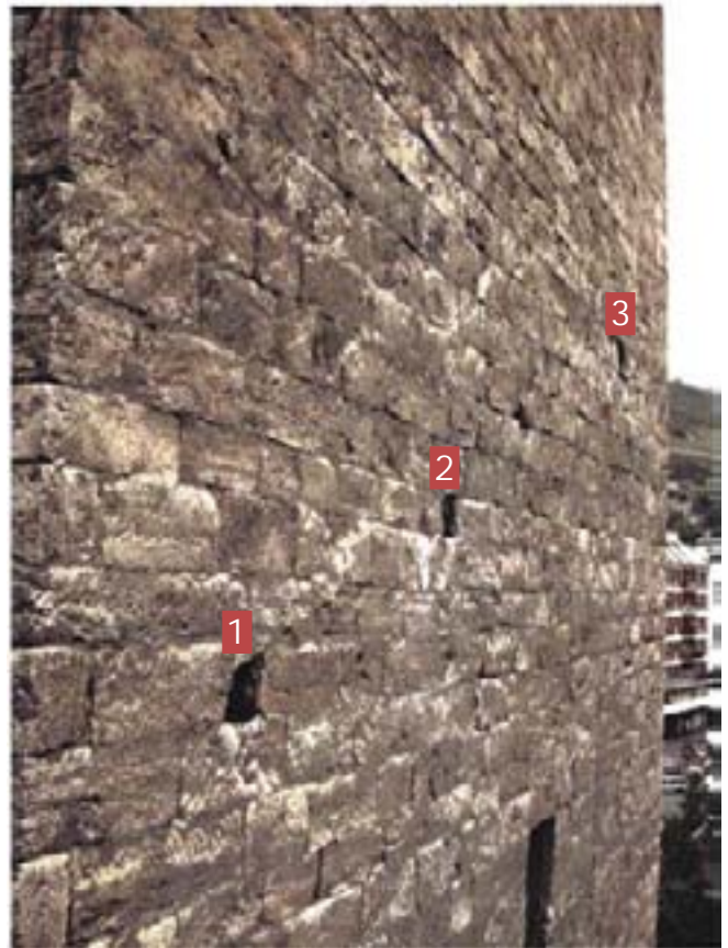
25. L'allineamento delle buche pontaie sul lato est. (M. Cortelazzo)
