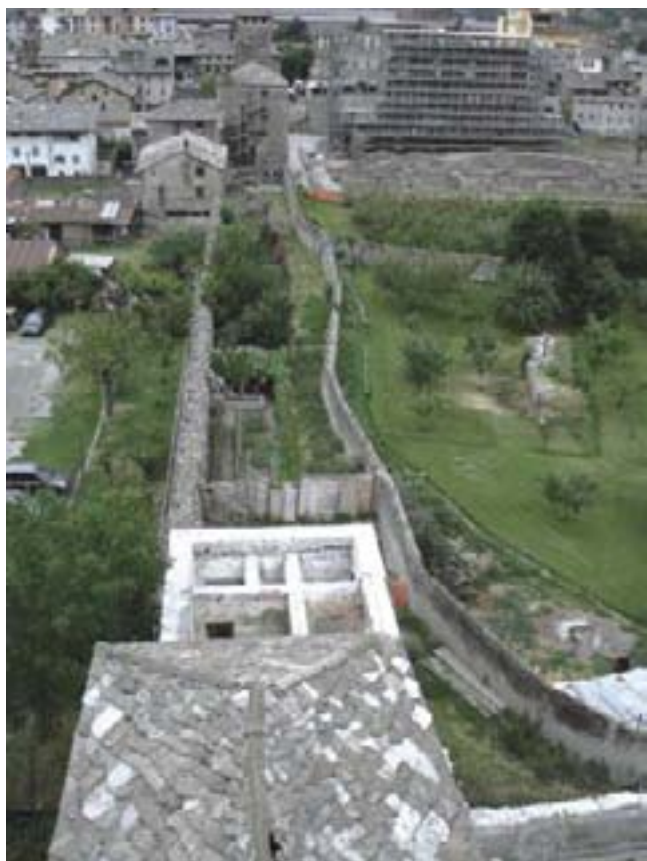
15. Tratto di cinta muraria lato est verso sud. (M. Cortelazzo)
