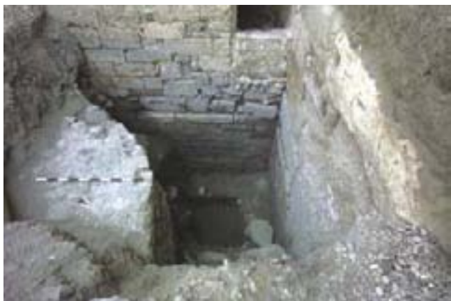
9. Il saggio esterno nell'angolo a nord-est tra la torre ed il muro di cinta. Nella parte inferiore è visibile al di sopra della risega di fondazione il paramento della cinta romana. (S.E. Zanelli)
