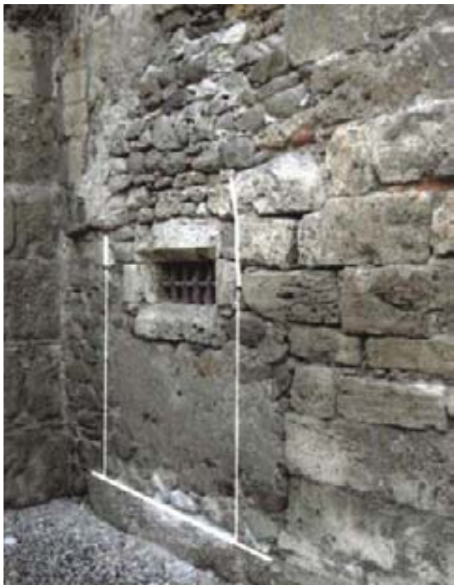
30. Tracce dell'esistenza di un portale sulla fronte nord accanto alla parete della torre. (M. Cortelazzo)
