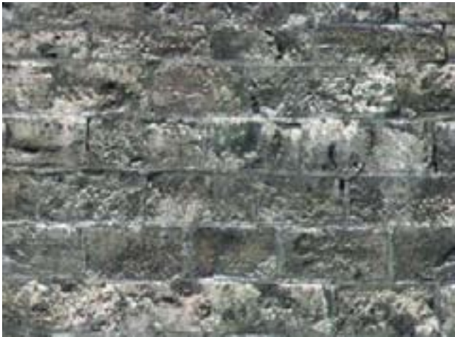
14. Particolare della stilatura "a nastrino sporgente" dei giunti sui corsi del lato nord della torre. (M. Cortelazzo)
