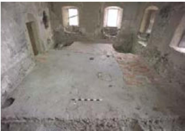
12. *Torrione, interno (amb. 40), pavimentazione in cocciopesto con vari rappezzi prima dell'inizio dei lavori. (S.E. Zanelli)*
