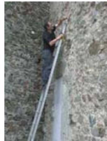
9. Torrione, parete esterna nord, prelievo di un trave delle impalcature per la ricostruzione del 1261. (M. Cortelazzo)
