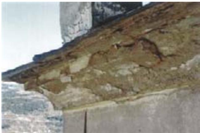
2. Particolare del cornicione alla base della cuspid: evidente il deterioramento dell'intonaco. (F. Accordi)
