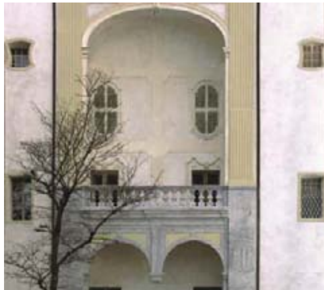
12. Fronte est: particolare della facciata dopo il restauro. (R. Focareta)
