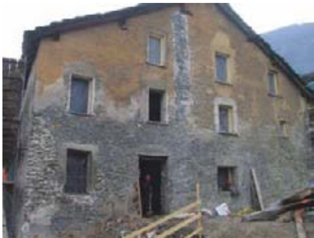
22. La grandze prima dell'intervento di recupero. (Impresa Orion)
