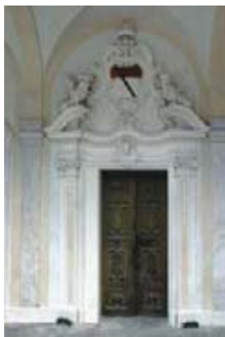
14. Fronte sud: portone d'ingresso dopo il restauro. (Zoppoli & Pulcher)
