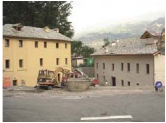
25. Vista d'insieme da sud durante i lavori. (A. Novel)
