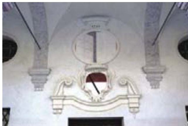
13. Fronte nord: decorazione a stucco dopo il restauro. (Zoppoli & Pulcher)
