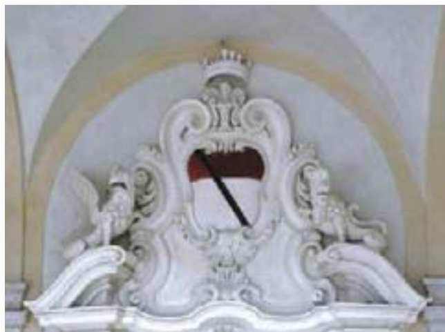
19. Fronte sud: decorazione a stucco sopraporta dopo il restauro. (Zoppoli & Pulcher)
