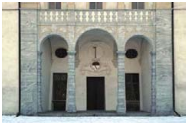
11. Fronte nord: particolare dopo il restauro. (Zoppoli & Pulcher)
