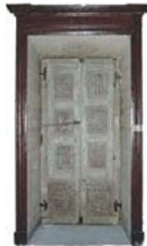
21. Primo piano, salone: serramento interno, decorazione a velario durante il restauro. (Zoppoli & Pulcher)
