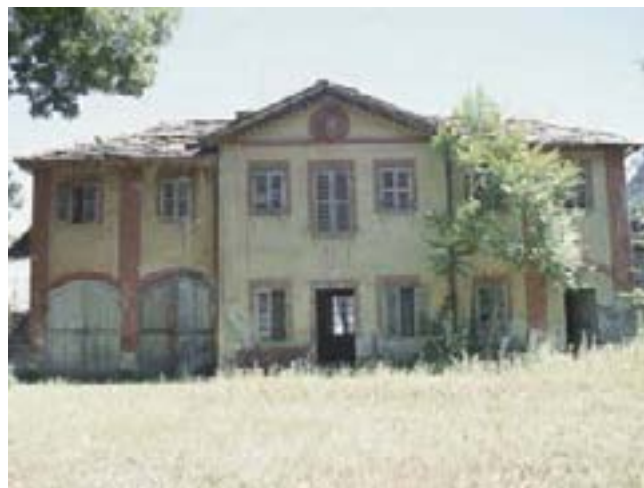
23. Le scuderie prima dell'intervento di recupero. (P. Fioravanti)
