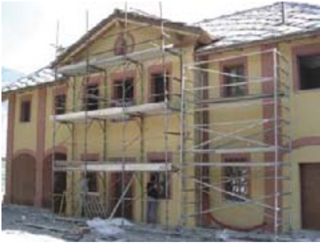
24. Le scuderie durante l'intervento di recupero. (A. Novel)
