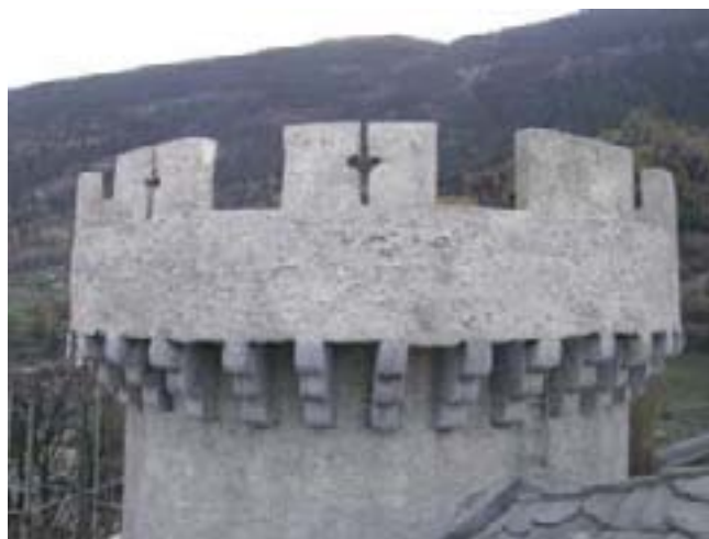
16. Torre sud-est dopo il restauro. (N. Dufour)
