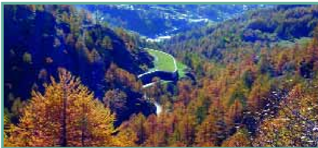
Galleria paravalanghe sulla S.R. n.46 in località Singlin di Valtournenche
