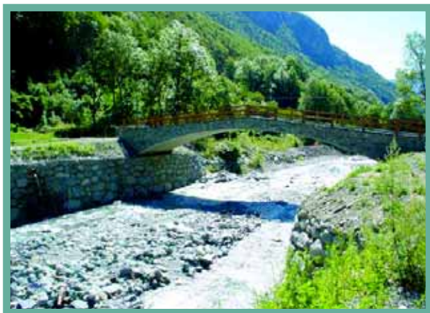
Ponte sul torrente Marmore in località Champlong nel comune di Châtillon
