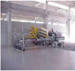
Trattasi della realizzazione di pavimenti industriali in cls con interposta rete elettrosaldata e trattamento superficiale con spolvero al quarzo o resine epossidiche, con eventuale esecuzione di giunti tecnici di dilatazione.
