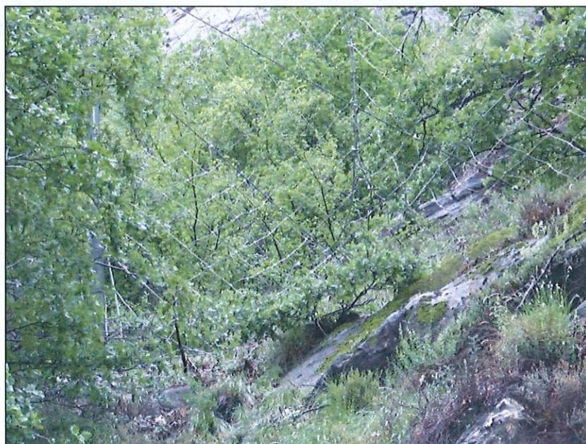
A cavallo tra il 2009 e il 2010, l'A.N.A.S. ha realizzato delle nuove imponenti opere: sono state infatti poste vaste superfici di reti armate e, a monte del settore della cabina in progetto, della barriere elastoplastiche da 3.000 kJ.
