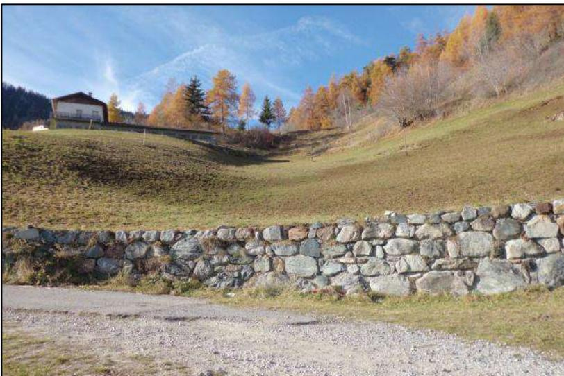
Vista da valle del primo tratto da intubare, (dalla “vasca” al primo attraversamento della strada) con in evidenza anche il muro che dovrà subire modifiche per il passaggio del tubo
