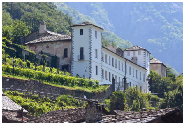
La facciata dopo i lavori di restauro
