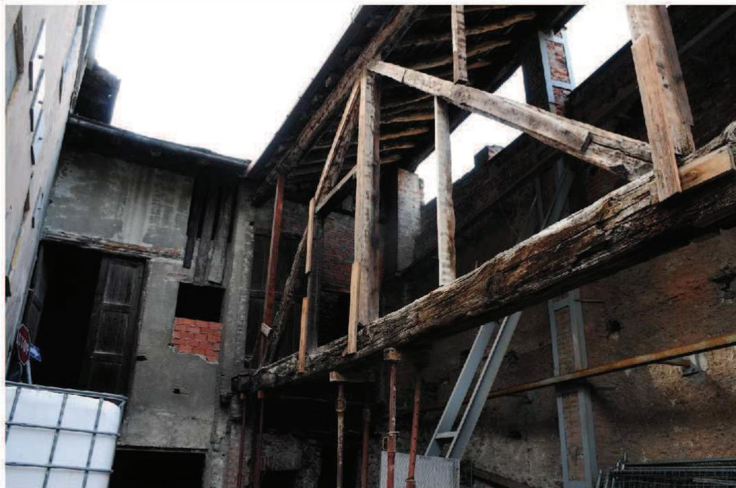
Fotografia n° 9: Corte settentrionale, la trave reticolare in legno.
