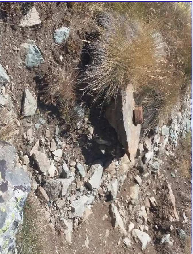
**Sez. C-D: riprofilatura piano di calpestio in seguito ad erosioni e realizzazione taglioni in pietrame.**
