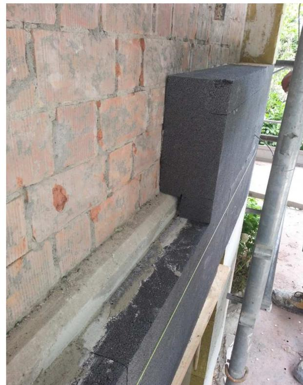
Isolamento esterno in corrispondenza del cordolo del piano intermedio, che è sporgente rispetto al filo dei muri superiore ed inferiore: il dettaglio è stato eseguito con particolare cura della sovrapposizione dell'armatura in fibra di vetro, al fine di scongiurare fessurazioni nella zona di discontinuità.
