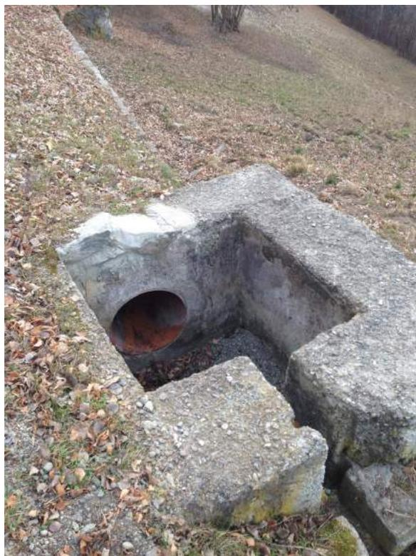
**FOTO 10** - POZZETTO A VALLE STRADA OGGETTO DI RIVESTIMENTO CON INTONACO IDRAULICO
