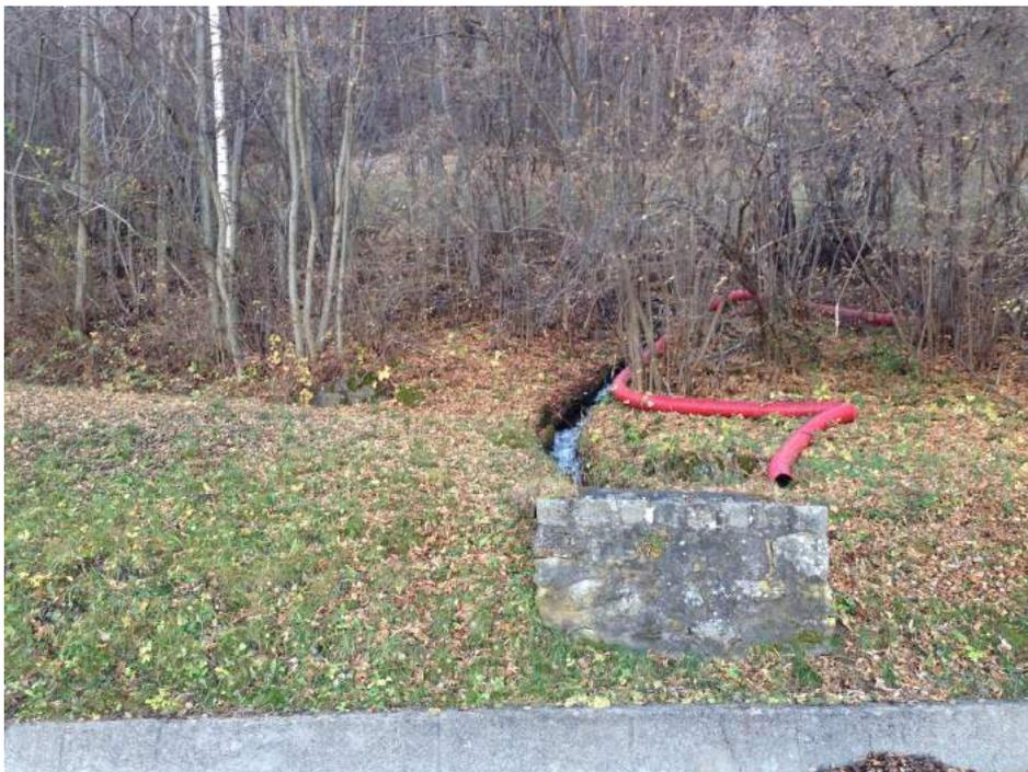
**FOTO 7**— VISTA DALLA STRADA REGIONALE DEL TRATTO DI CANALE “LESSERT” DA INTUBARE E VISTA DEL POZZETTO A MONTE STRADA REGIONALE OGGETTO DI RIVESTIMENTO CON INTONACO IDRAULICO
