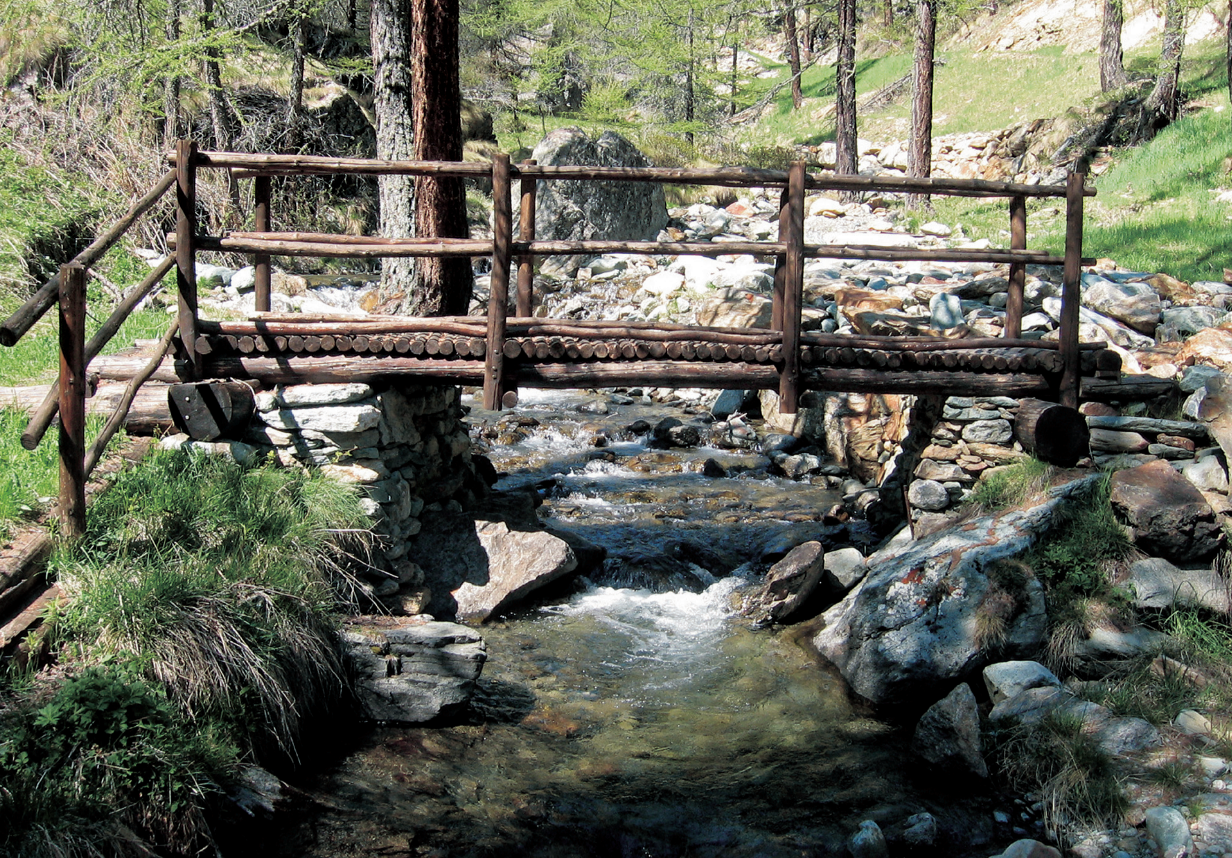
Ponticello sul Torrente Petit-Monde (Torgnon).
