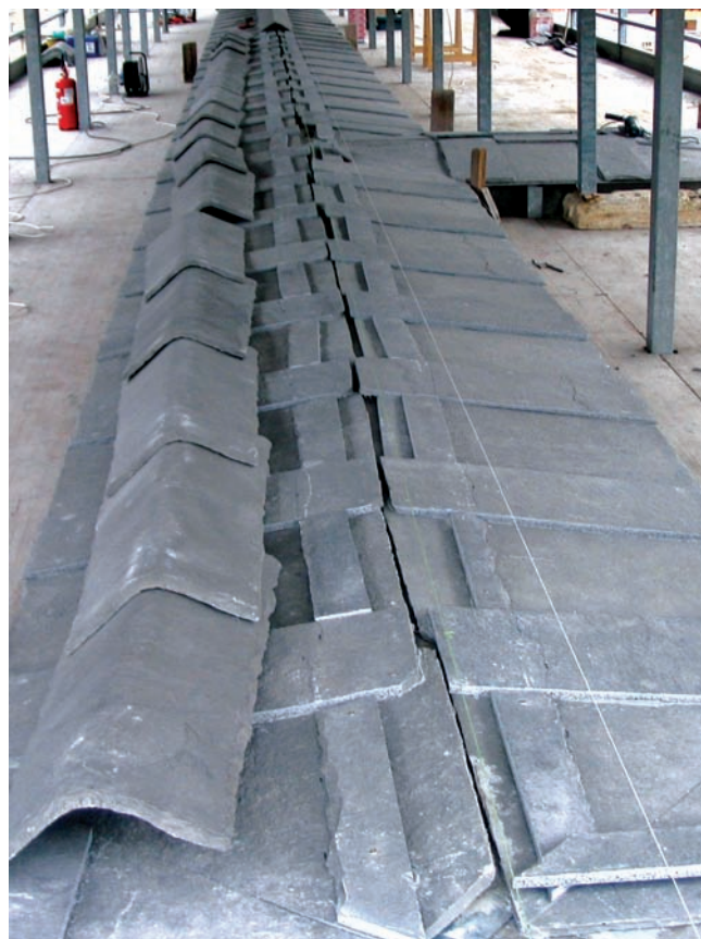
2. Fase finale della posa in opera delle lose in resina. (R. Ferrod)
