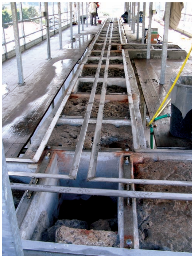
1. La capriata in acciaio inox. (R. Ferrod)
