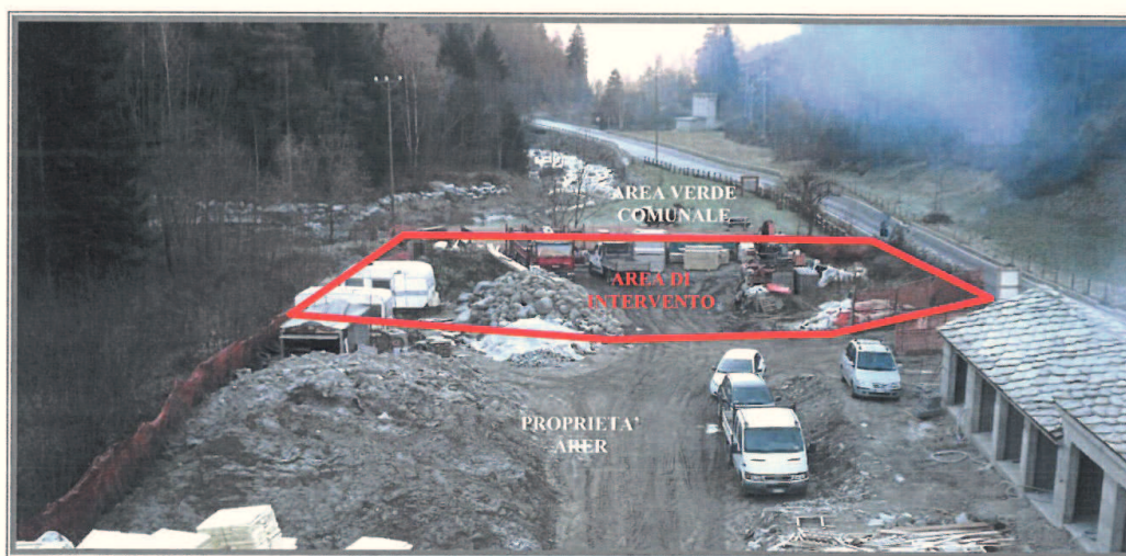
Area oggetto di intervento – Vista da nord
