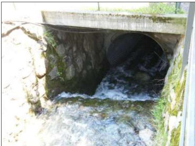
FIGURA 6-12 SEZIONE DI IMBOCCO ALLA TOMBINATURA
