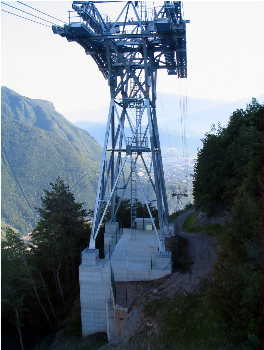
**Figura 128 – Foto di un sostegno**
