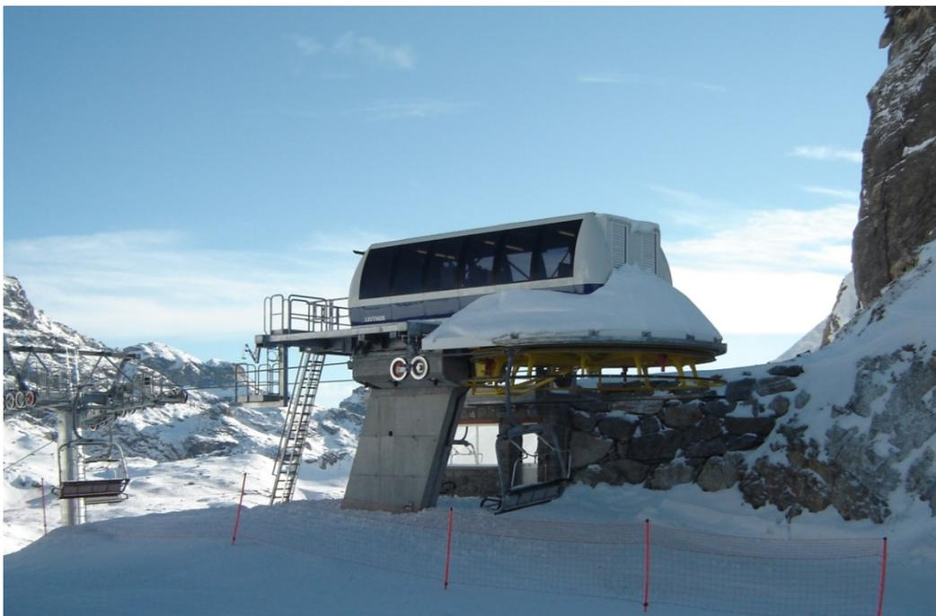
Figura 39 – Stazione motrice di impianto ad attacchi fissi
