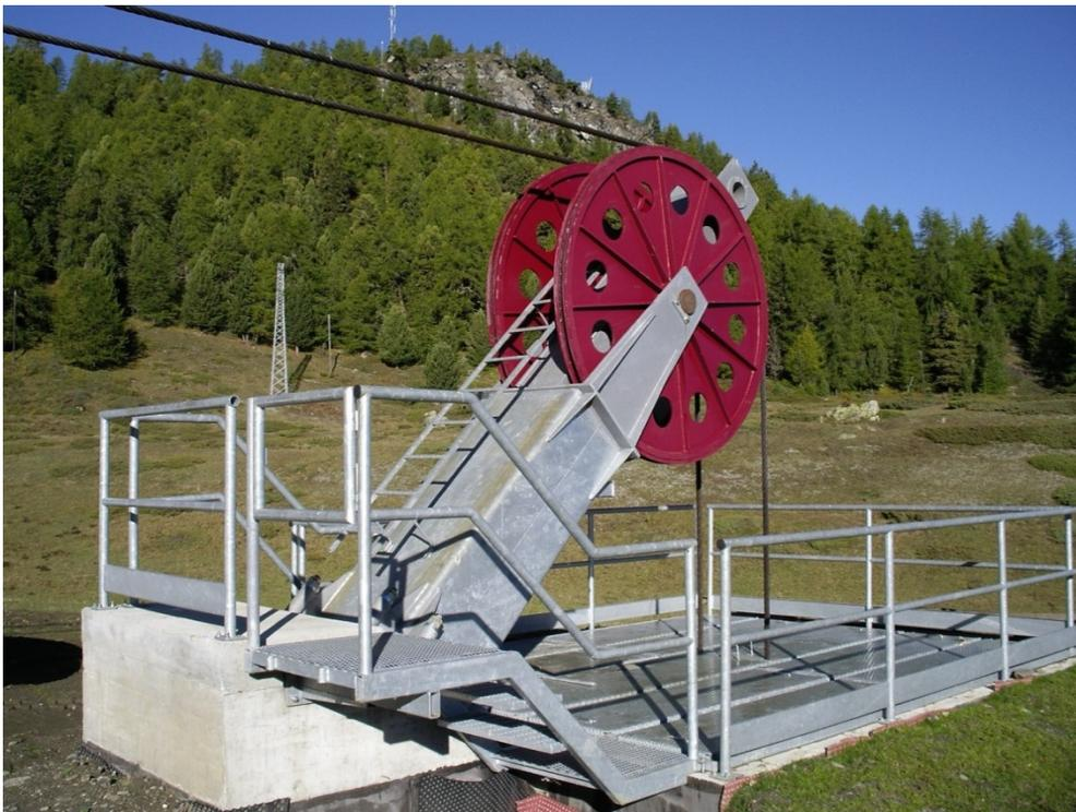
Figura 32 – Puleggia di deviazione della fune tenditrice al contrappeso, situato nel pozzo
