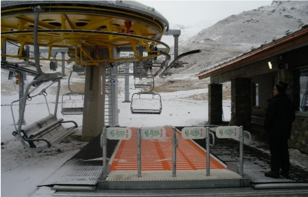
**Figura 100 – Banchina di imbarco**
