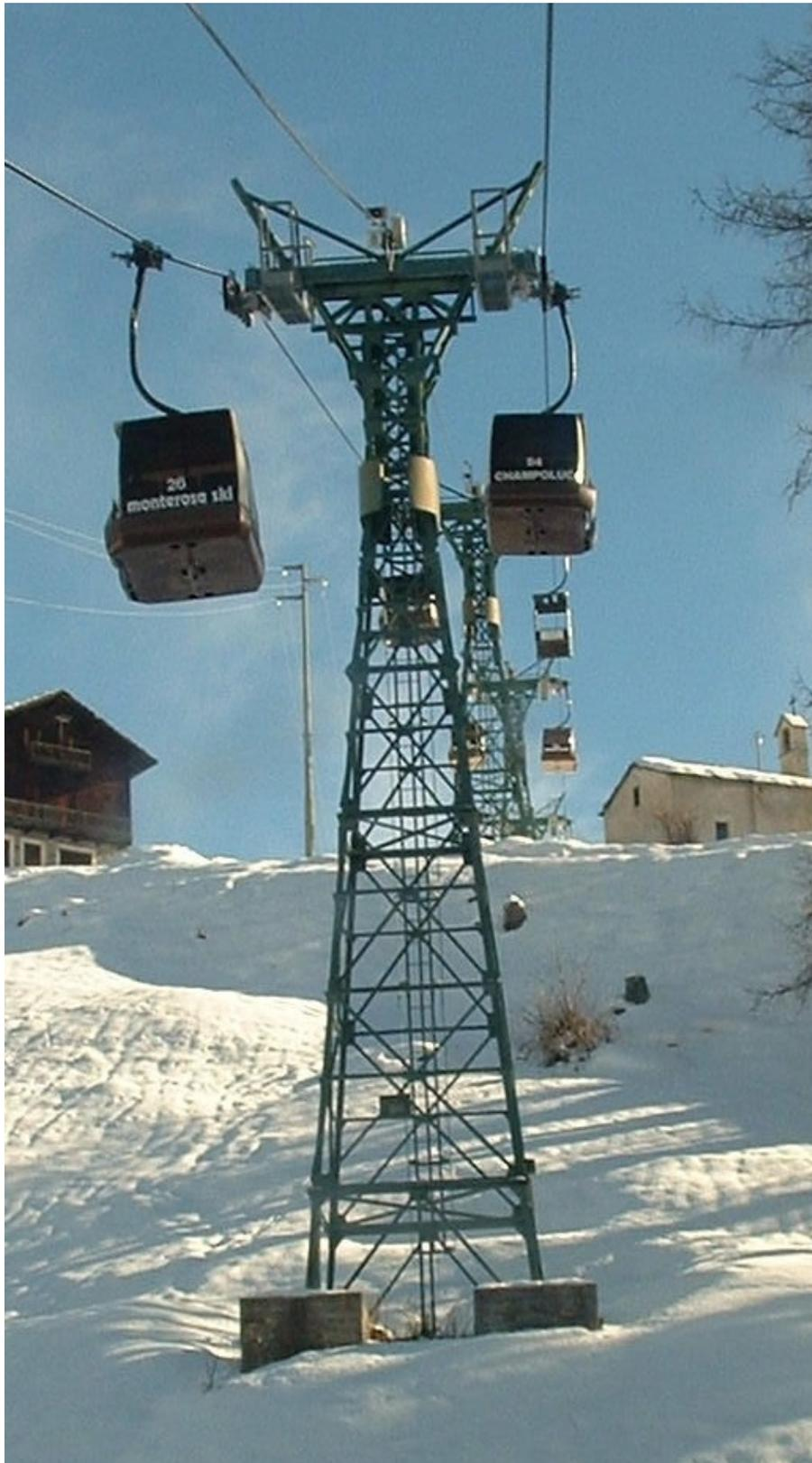
Figura 66 – Sostegno a traliccio utilizzati per fusti di altezza notevole per la loro maggiore rigidezza
