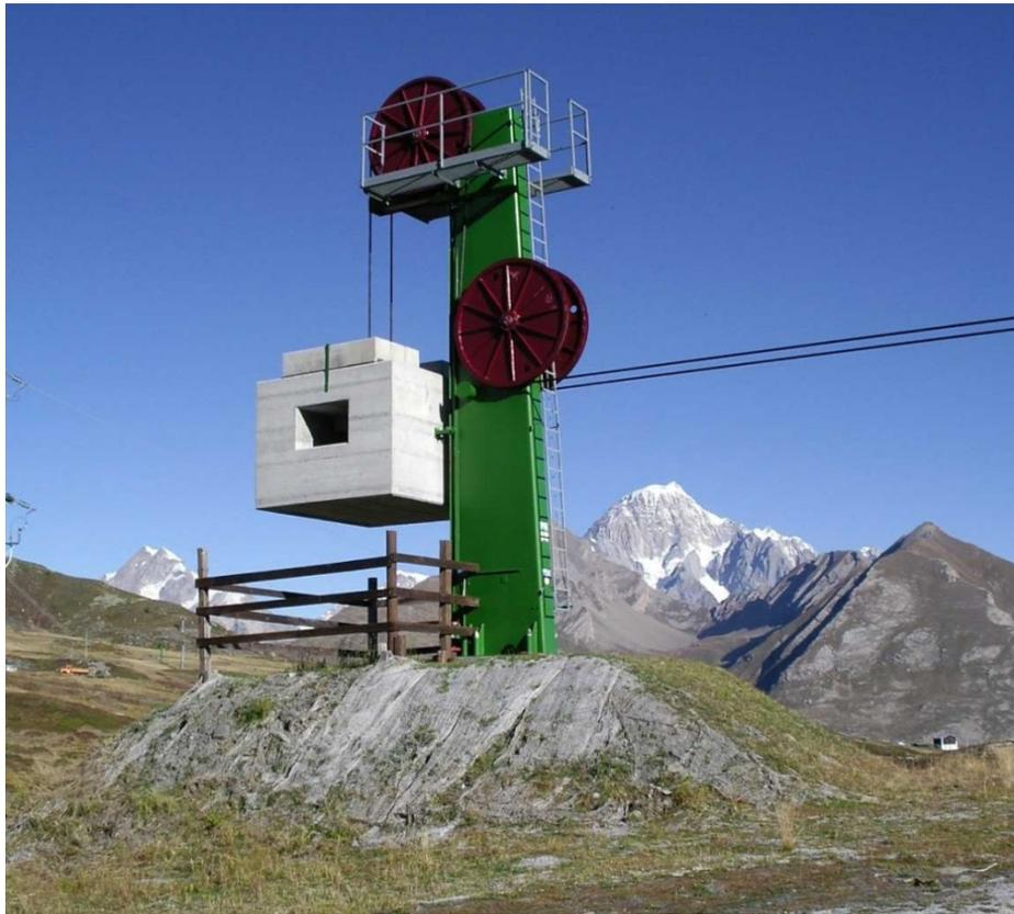
Figura 31 – Sistema a castello per tensionamento
