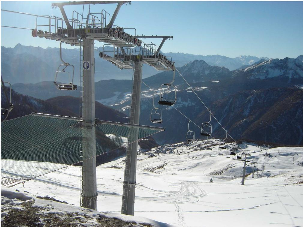
Figura 103 – Opera di protezione presso stazione di monte
