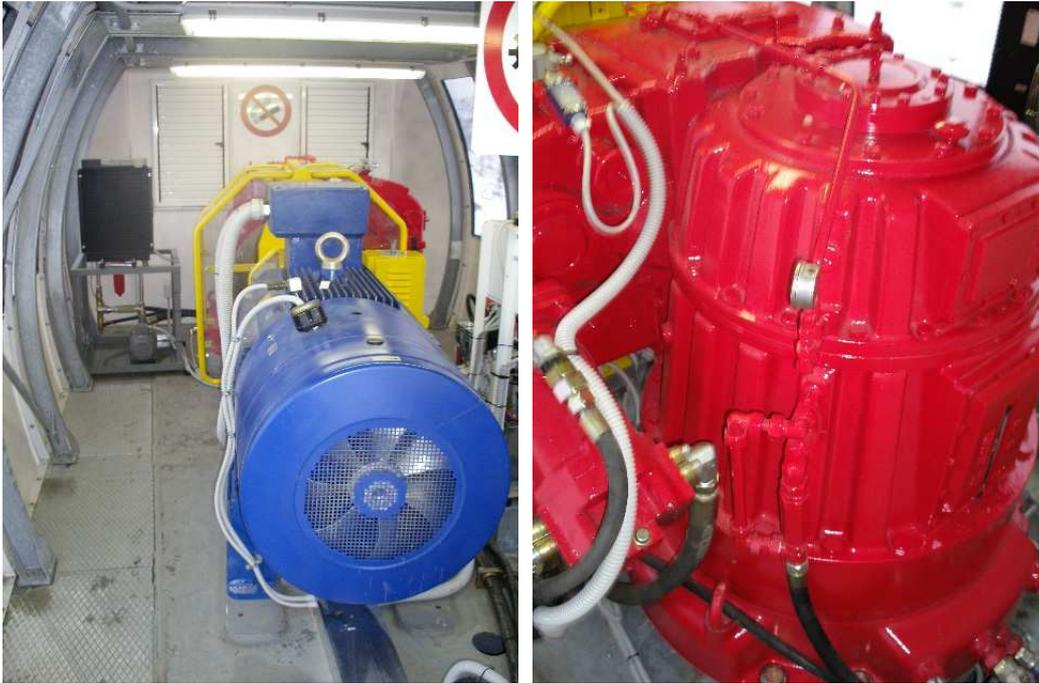
**Figura 12 – Motore e riduttore di un impianto ad attacchi fissi**
