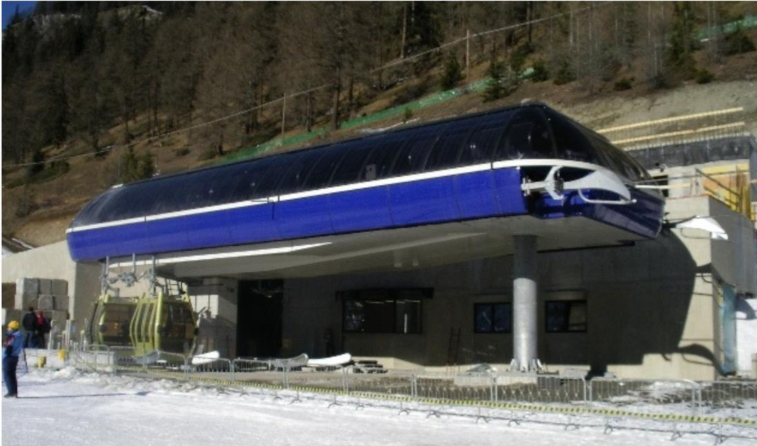
**Figura 42 – Stazione di una telecabina ad agganciamento automatico**
