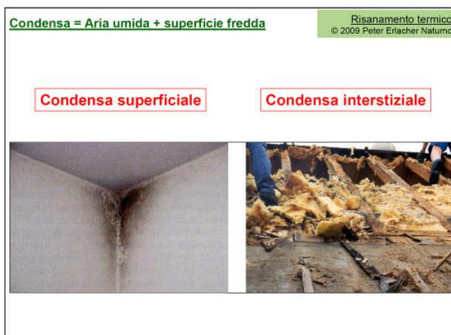
Per ciò che riguarda la diffusione al vapore, non ci sarà nessun problema di traspirabilità se non andiamo ad interferire nel passaggio dell'umidità. La fibra di legno abbinata ad un intonaco in calce o ancora meglio ad uno in argilla risulta ideale in quanto la quantità di condensa che potrebbe formarsi, ad esempio in un bagno comunque areato, è sicuramente inferiore alla capacità igroscopica molto alta dei due materiali.
